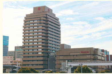
■本社(多摩センター駅前)
